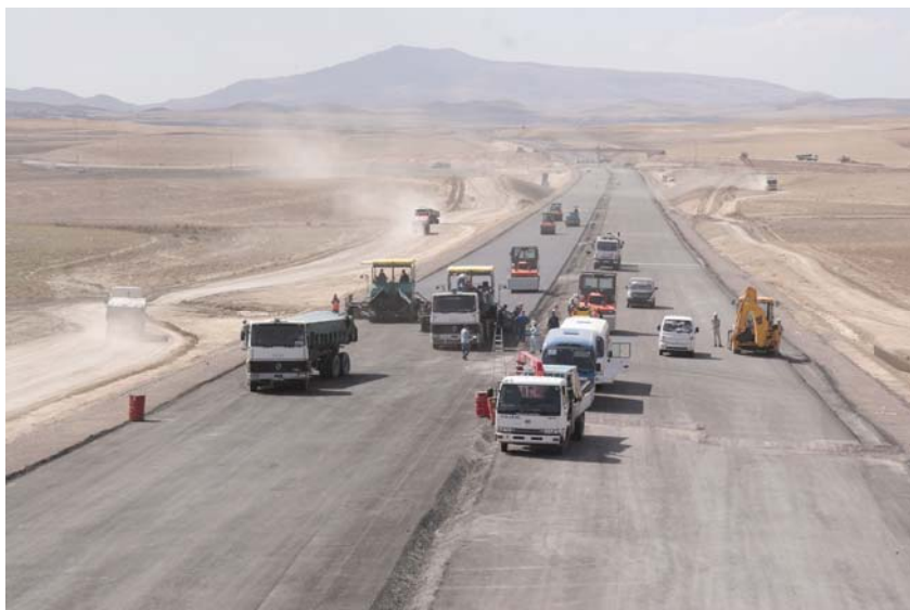
Gradilište na odsječku autoceste u Alžiru
