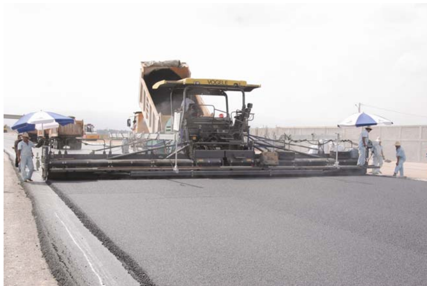
Izrada završnog sloja asfalta
