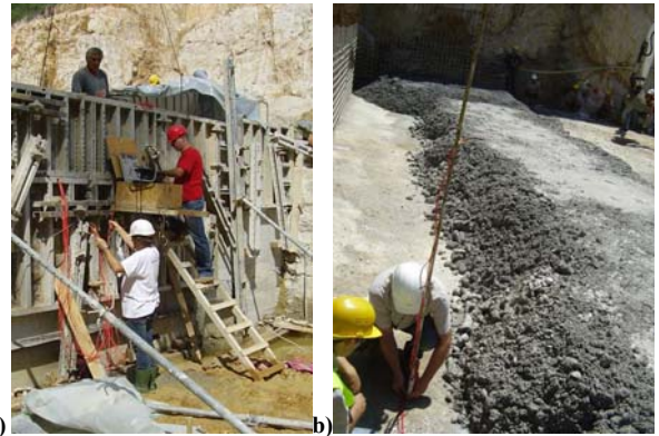
Slika 9. Mjerenje razvoja temperature tijekom betoniranja
