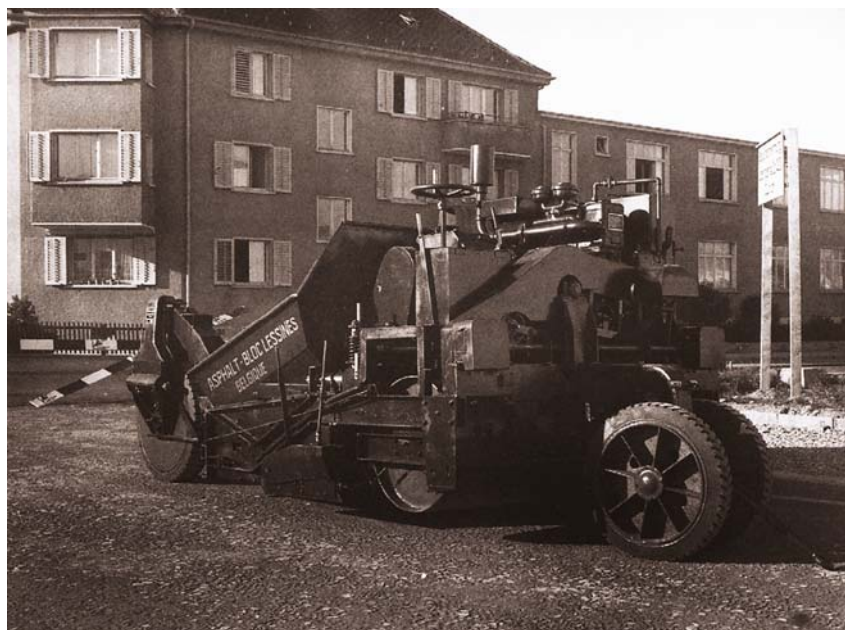
Polaganje asfalta sredinom sedamdesetih godina prošloga stoljeća
