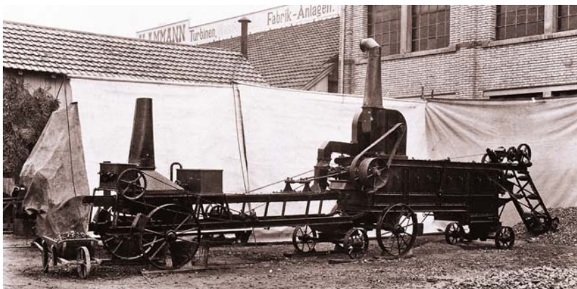
Prvi patentirani stroj za kontinuirano polaganje asfaltnih mješavina
