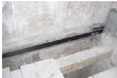
Ugrađena karbonska lamela u zoni sidrenja
