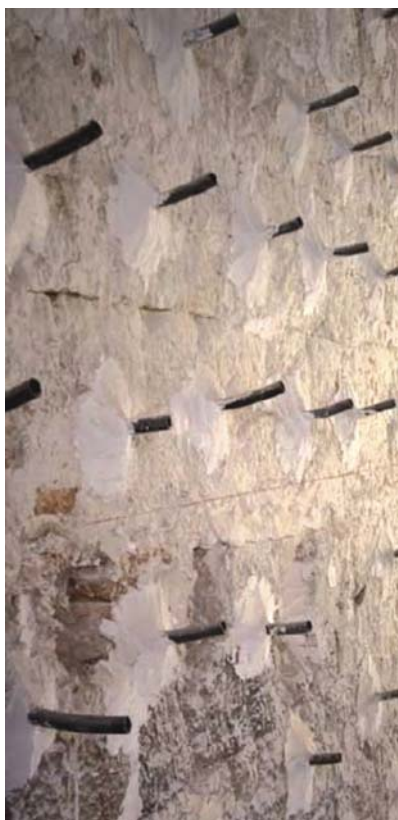
Rapored injektora po kamenom zidu prije injektiranja
