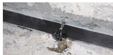
Detalj zone sidrenja sa završnom obradom kvarcnog pijeska
