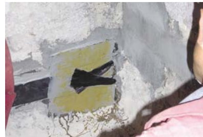
Preklapanje karbonske užadi na prethodno naneseu epoksidnu impregnaciju
