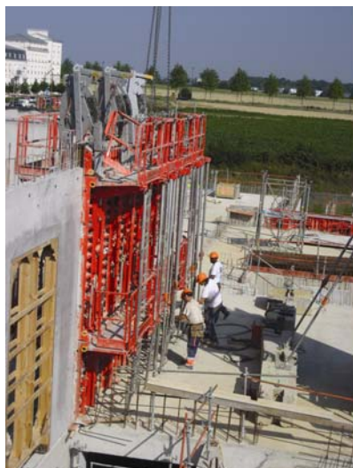
Slika 2. Ljestve i zaštitna ograda u sastavu su oplata
