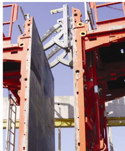
Slika 3. Montaža Outinord oplata
