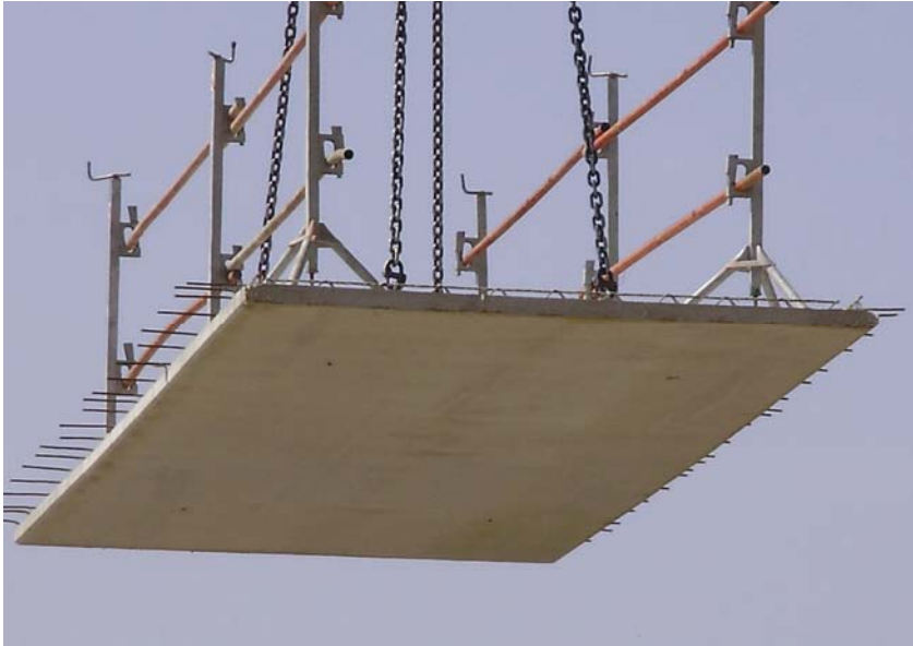
Slika 4. Betonski element s montiranom ogradom
