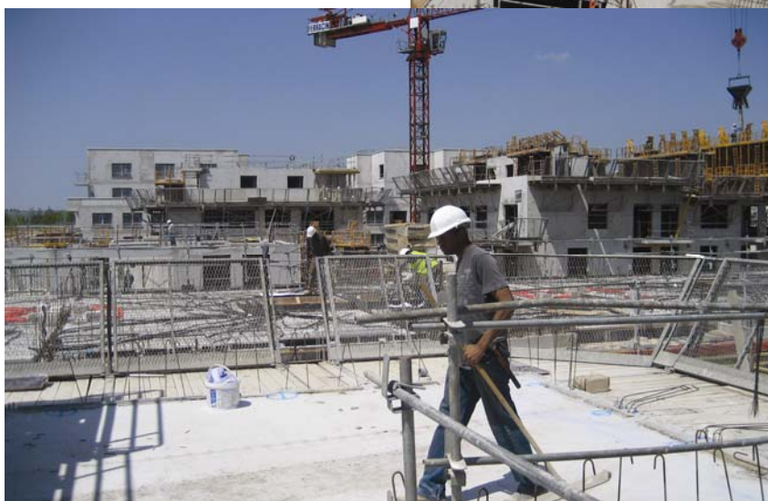
Slika 1. Gimnazija u izgradnji (faza grubih građevinskih radova)
