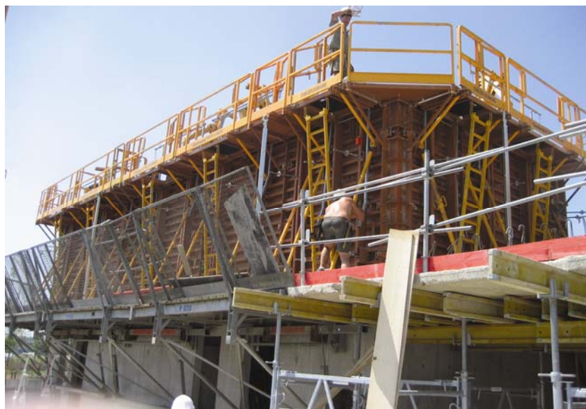
Slika 2. Ljestve i zaštitna ograda u sastavu su oplata
