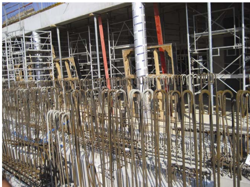
Slika 6. Savijeni su svi krajevi armature
