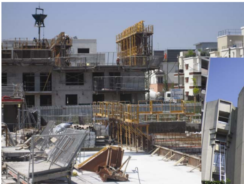
Slika 7. Gradilište stambene zgrade sa zaštitnim ogradama
