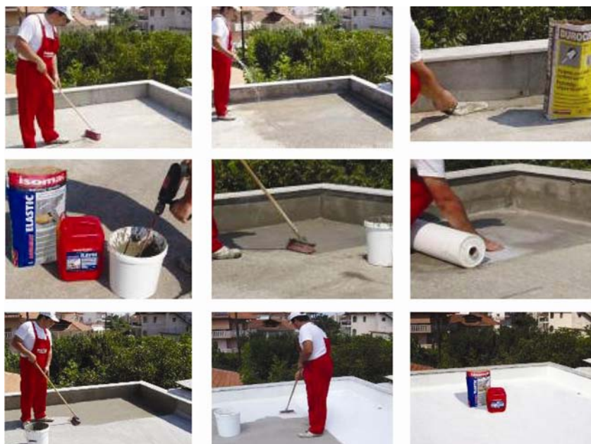
Izvedba elastičnoga dvokomponentnog cementnog premaza za hidroizolaciju
