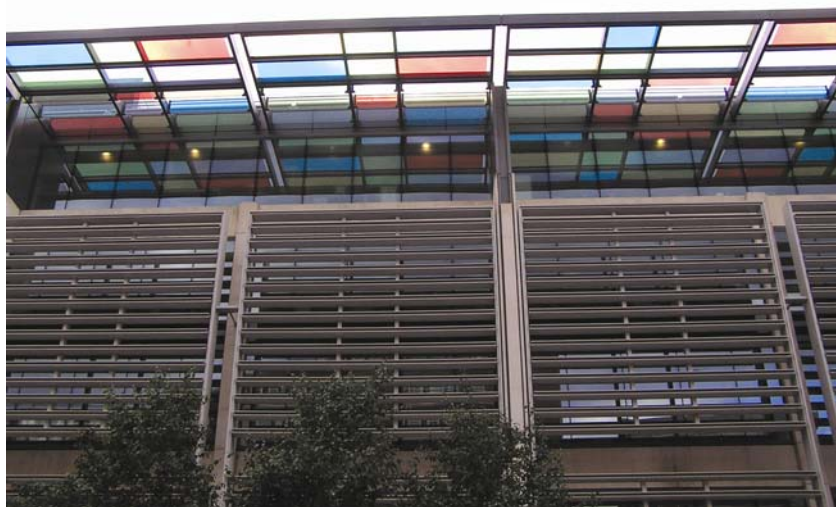
Različite boje stakla različito raspršuju sunčevo zračenje
