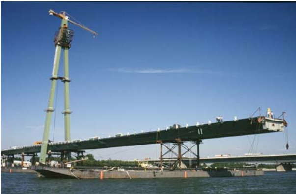
Slika 7. Doprema plovnim putem nosive konstrukcije (oba broda usidrena i povezana)
