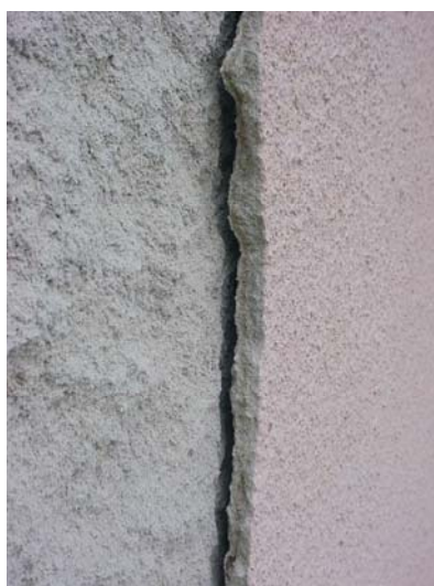
Slika 3. Odvajanje međusloja ljepila od toplinskoizolacijske žbuke
