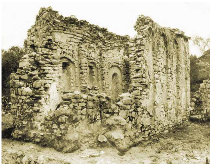
Crkva Sv. Petra prije rekonstrukcije
