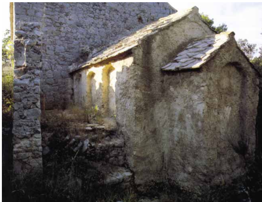
Crkva Sv. Ivan prije obnove
