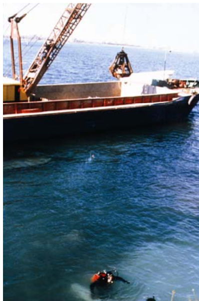
Slika 11. Ronioci upravljaju postavljanjem kamenih blokova
