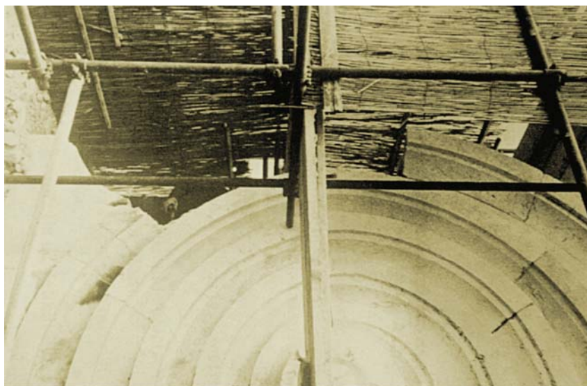
Slika 5. Stabilizacija konstrukcije mikrotrovnima na crkvi San Stae
