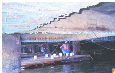
Slika 2. Zaštita očišćene armature antikorozivnim premazom Mapefer
