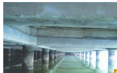
Slika 4. Nosači sanirani sustavom za obnovu armiranobetonskih konstrukcija
