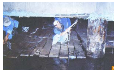
Slika 3. Oblaganje oštećenih nosača strojnim nanosom sanacijskog morta Mapegrout T60
