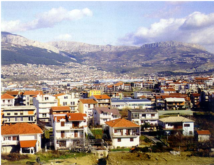
Područje Dragovoda u Splitu s mnoštvom bespravno izgrađenih kuća
