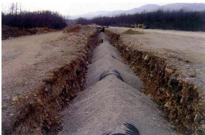
Polaganje cijevi za sustav zatvorene odvodnje
