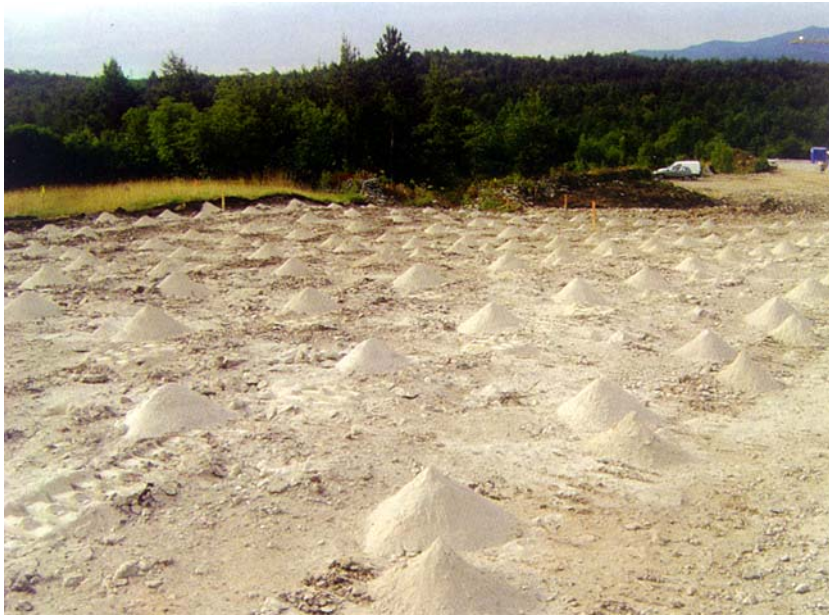
Cementna stabilizacija posteljice u čvorištu Rupa
