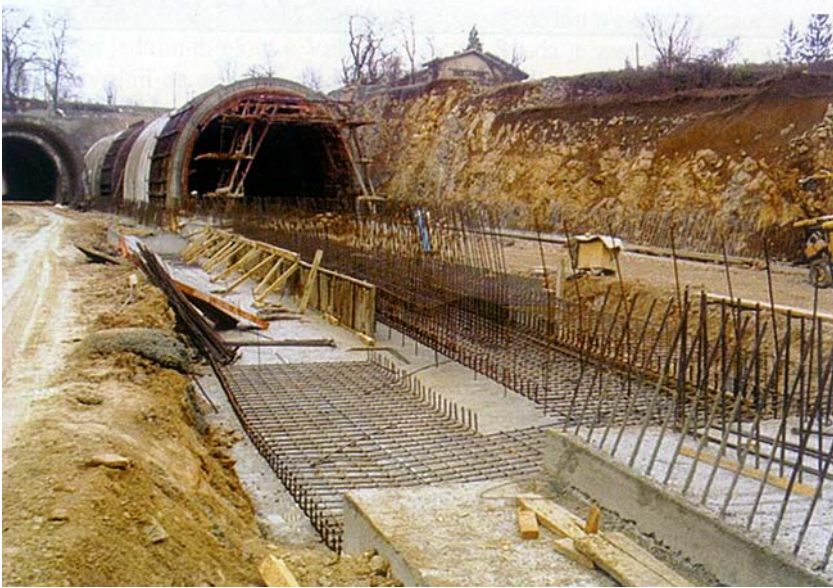
Gradnja portala tunela Jušiči i pristupa tunelu
