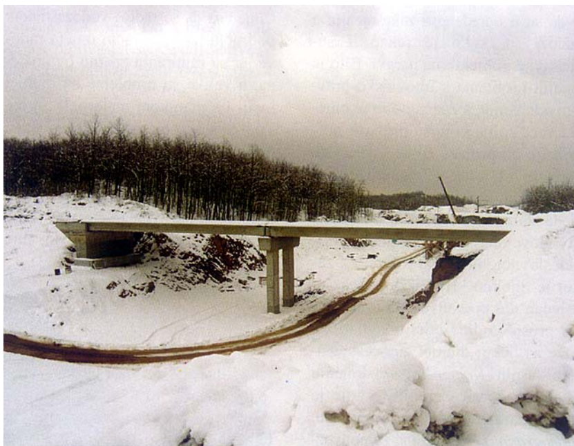
Gradilište vijadukt Miklavić 3 pod snijegom
