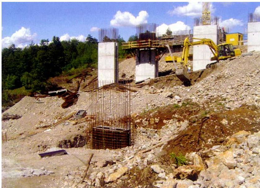
Gradnja stupova vijadukta Rupa
