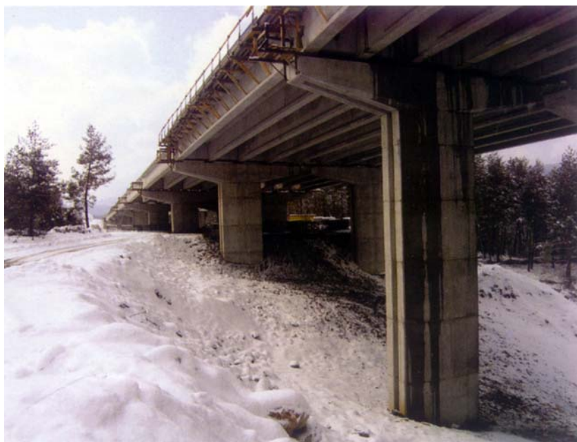
Pogled odozdo na gotovo izgrađeni vijadukt Rupe
