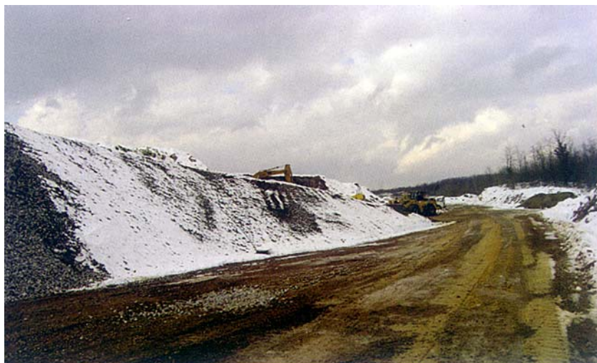
Faza gradnje autoceste u čvorištu Permani
