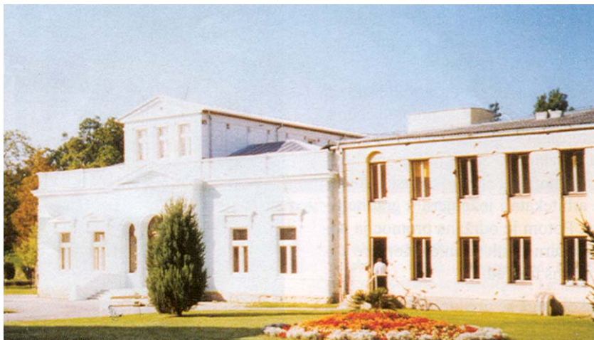
Zgrada hidroterapije nakon restauracije
