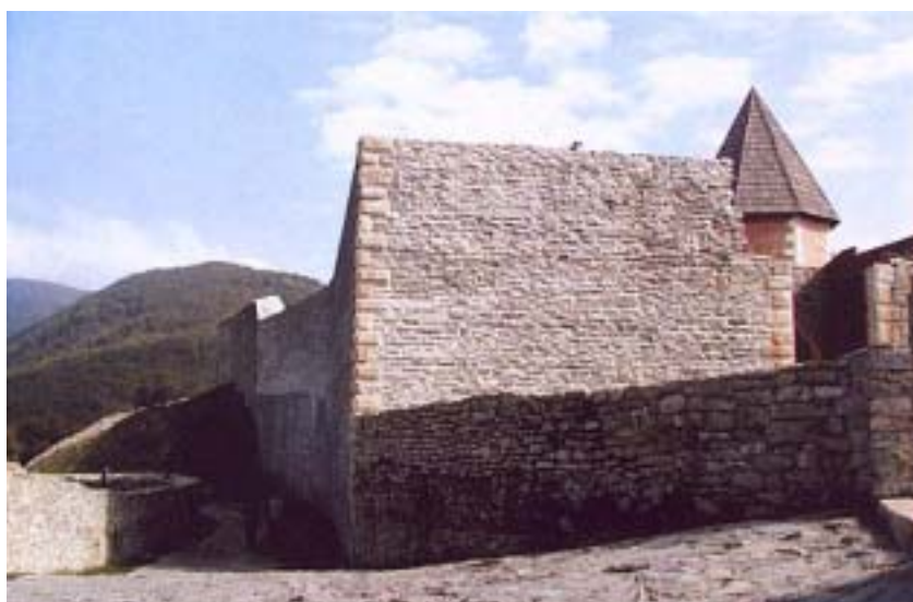
Dio sjevernih zidina utvrde
