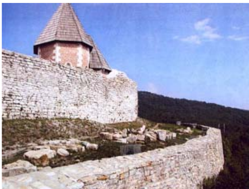
Dio južnih zidina utvrde
