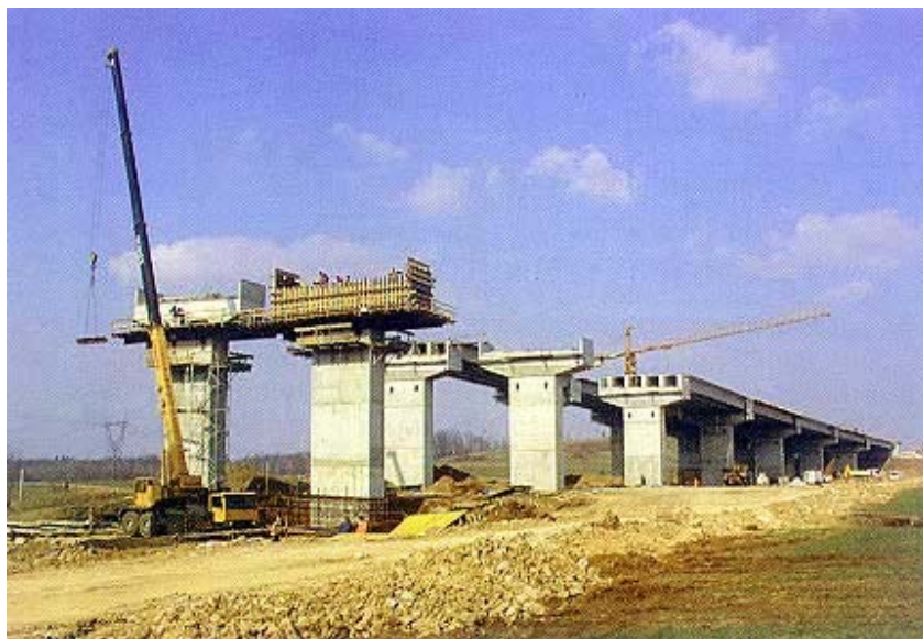
Gradilište vijadukta Varoš
