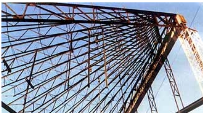
Spoj čeličnih i betonskih nosača krovne konstrukcije
