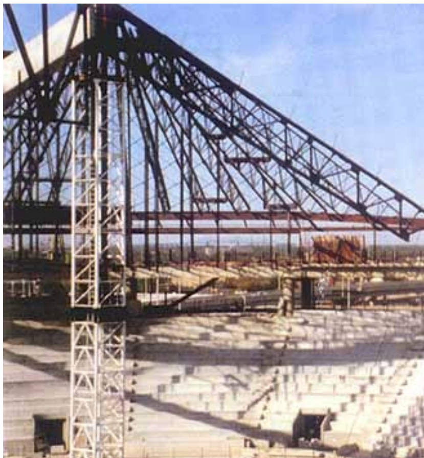
Pogled na dio tribina i krovnu konstrukciju dvorane
