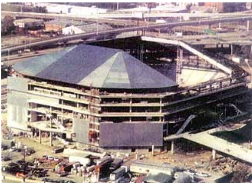
Završni radovi na konstrukciji dvorane i krova
