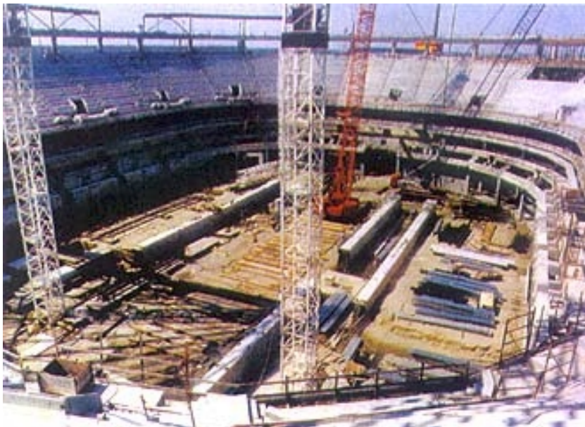
Armiranobetonski nosači radeni su u središtu dvorane
