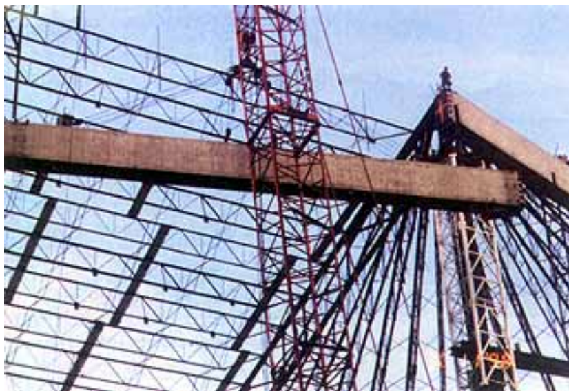
Montaža nosača krovne konstrukcije
