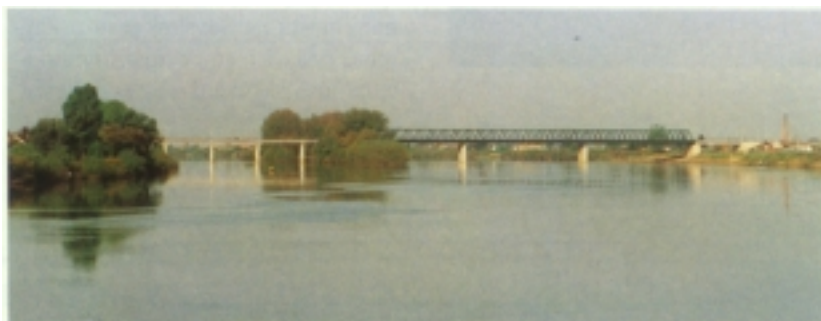
Pogled na cijeli obnovljeni most u Slavonskom Brodu
