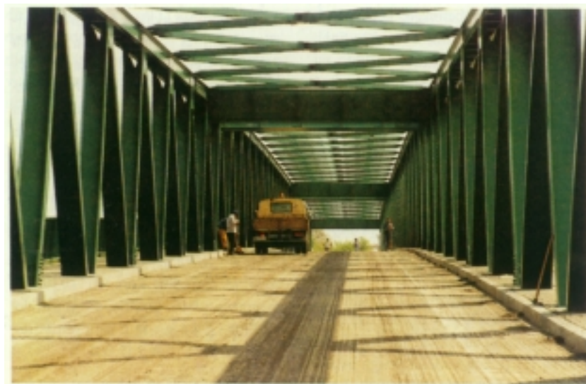
Završni radovi na kolniku mosta
