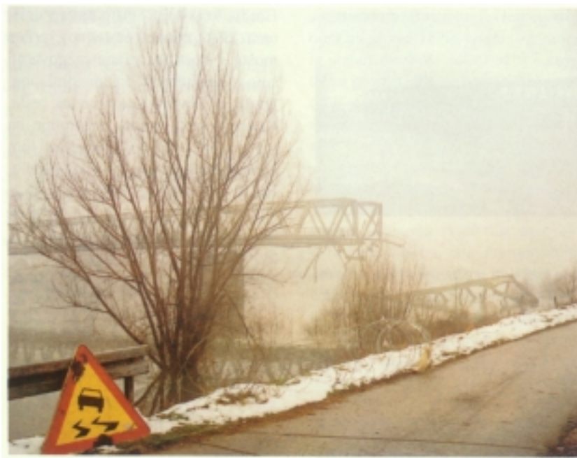
Srušeni most između Stare i Bosanske Gradiške
