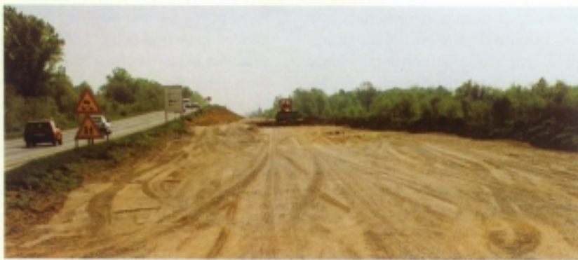
Gradilište autoceste ispred prijelaza preko željezničke pruge
