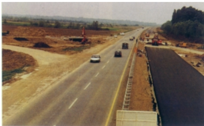
Radovi na dionici autoceste Oprisavci-Velika Kopanica
