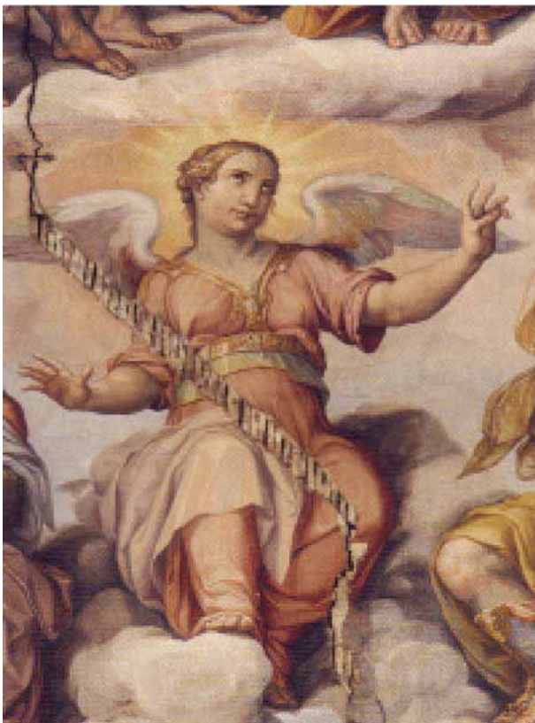
Slika 32. Vidljive pukotine u kupoli
